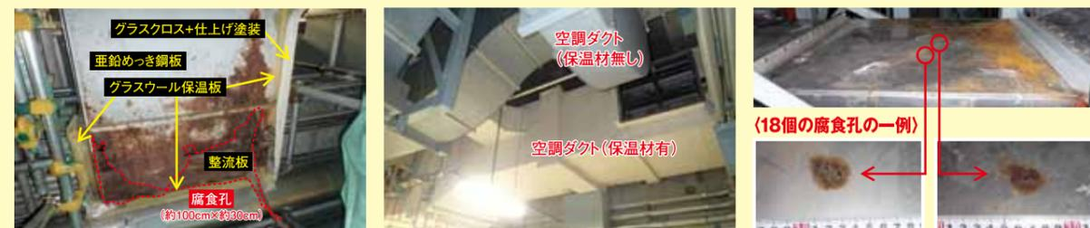
H28.12.08に確認した腐食孔(保温材取外し後) 空調ダクトの一例
