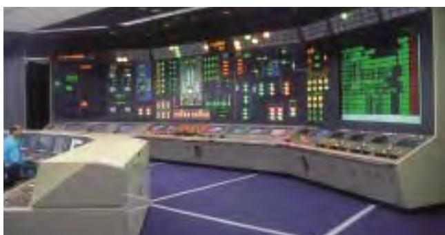
3号機の中央制御盤と同型の訓練シミュレータが公開されました。このABWR用中央制御盤は、1,2号機にはない大型表示盤を採用し、運転員が運転状況を一目で把握できるなどの特徴があります。
