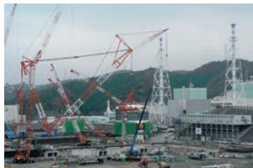
3号機建設現場
