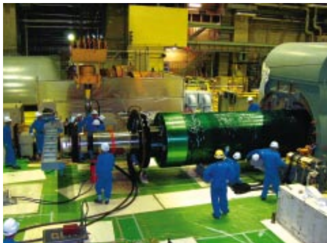
2号機の第11回定期検査の様子
