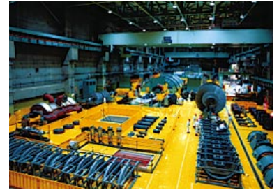
発電機タービンの開放検査
