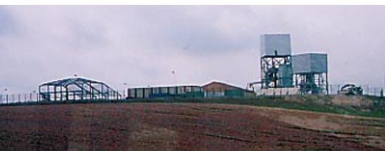
広大な農地に建設中のビュール地下研究所(フランス)
