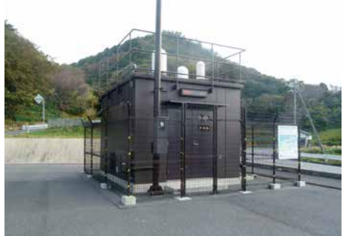
片句局 建屋屋上に放射線及び気象を観測する機器を設置
