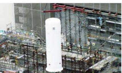
フィルタ付ベント設備(フィルタ設置の様子)
