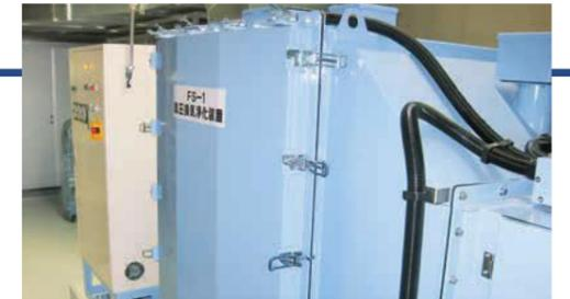
放射性物質の流入を防ぐためフィルターを通した風を送り込み、施設内の気圧を高めるための装置（松江市内の社会福祉施設の例）
