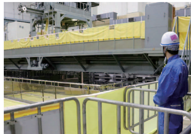
燃料取扱機を使って燃料プールから原子炉内へ燃料を移動させる様子
