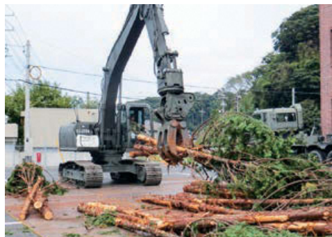
障害物(木材)の撤去
